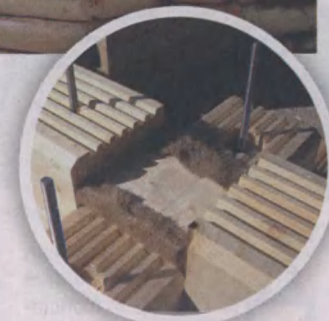
На стройплощадку привозят уже выставивший сруб с пронумерованными венцами
