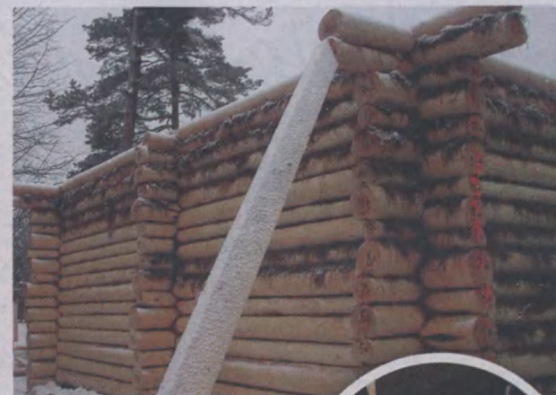
На стройплощадку привозят уже выставивший сруб с пронумерованными венцами
